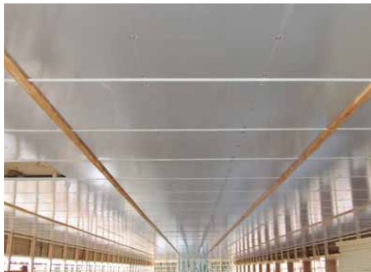
鶏舎天井施工例
